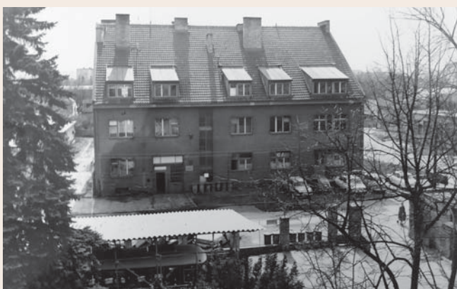
Pracoviště Praha 10 – Strašnice, Třebostická 12
